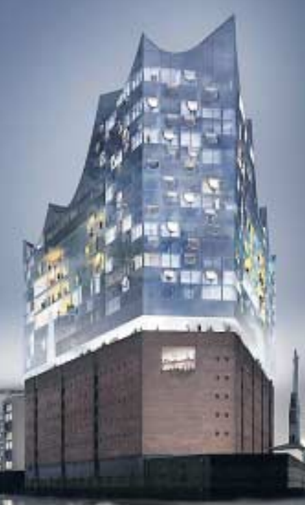
Es gibt schon wieder neue Spekulationen über die Kosten für die Elbphilharmonie Foto: HERZOG DE MEURON
